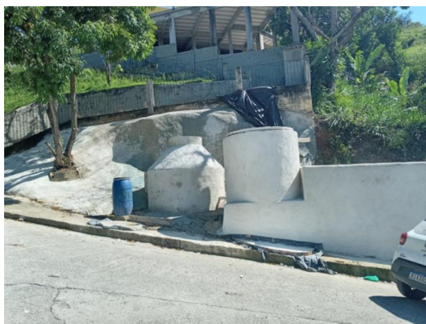
Foto 2: Construção do sistema de Biodigestor da Creche do Engenho Pequeno.
