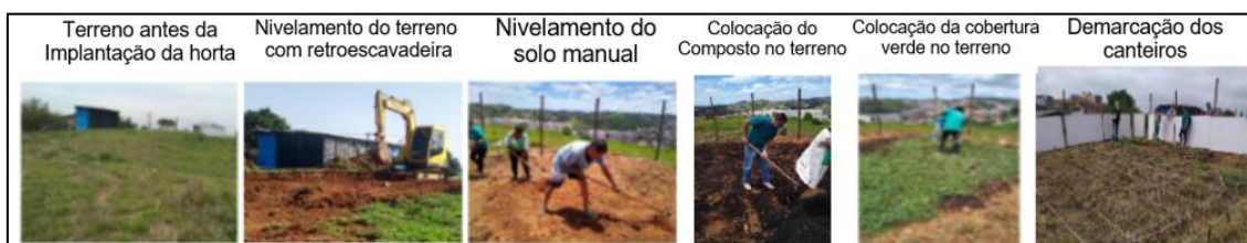
Figura 5 - Etapas: do nivelamento do terreno, colocação da cobertura verde, marcação dos canteiros e colocação do composto orgânico
